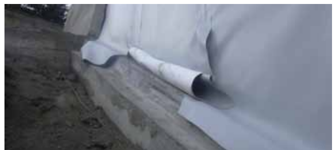
Conexión con la estructura de hormigón con la ayuda de las bridas / contrabrida
