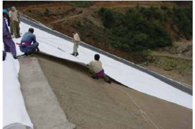
Colocación del geotextil
