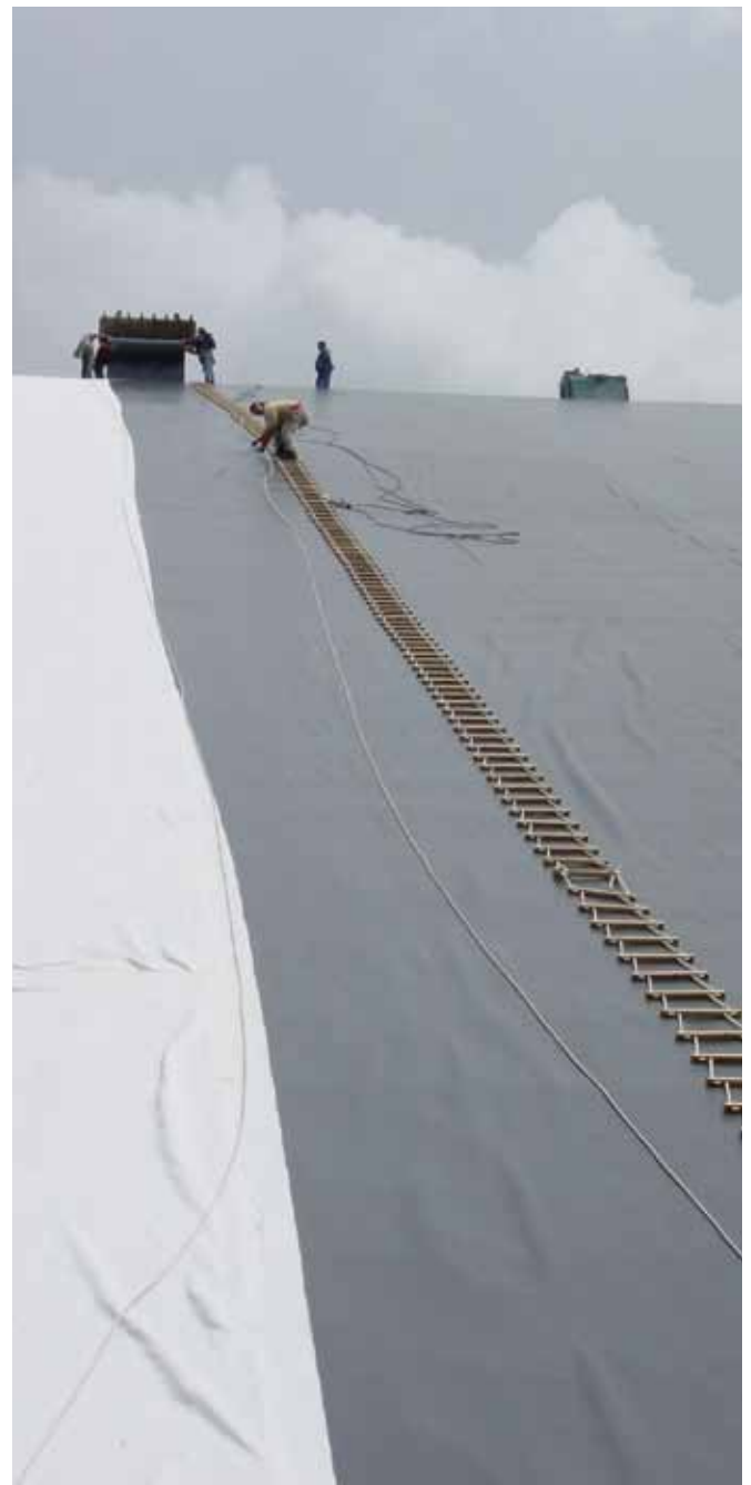
Doble soldadura con máquina automática de aire caliente
