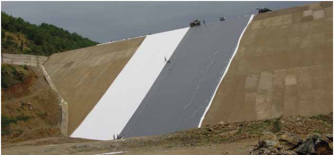
Colocación del geotextil
