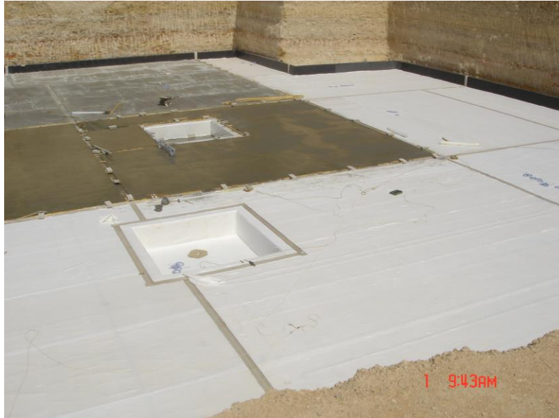
Ejecución del hormigón de protección
