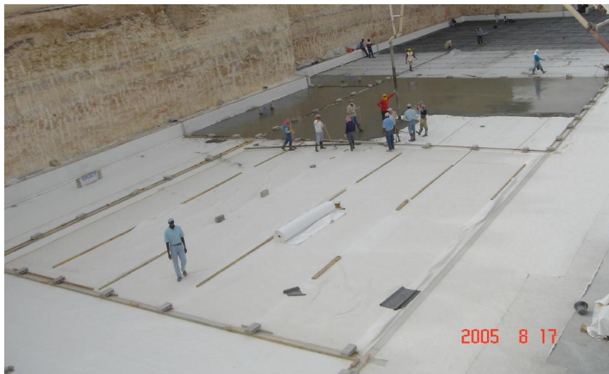
Instalación de Water Stops y ejecución del cemento protector
