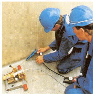
Prueba de Soldadura
