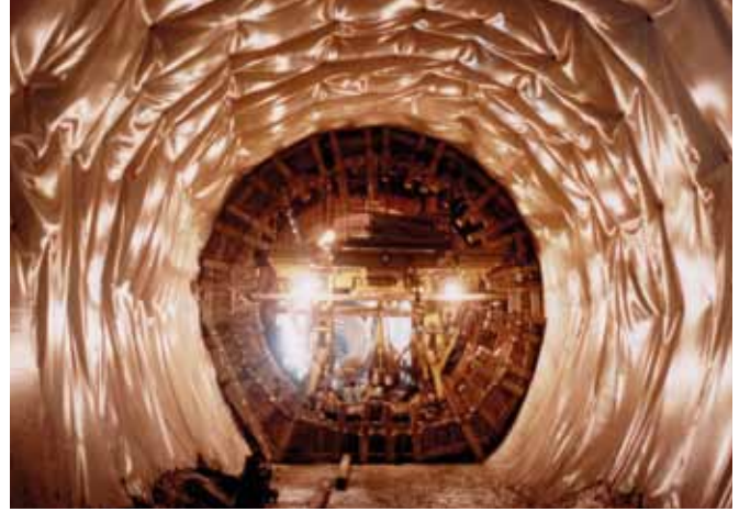
Fijación de la geomembrana a través de la soldadura directa
