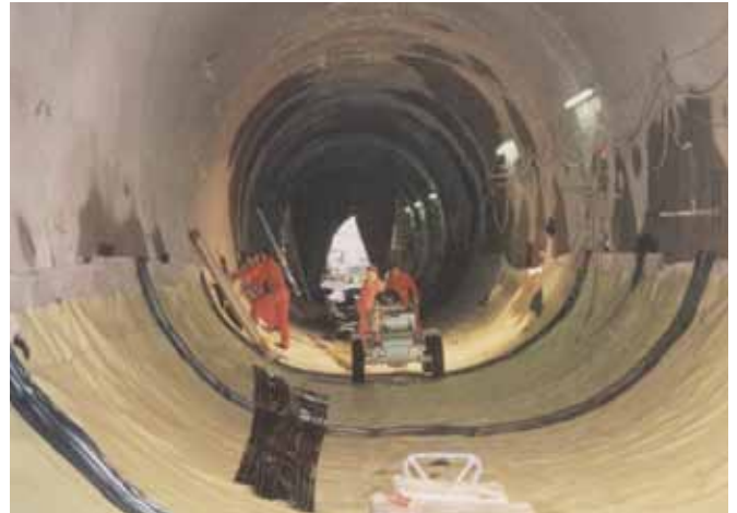
Instalación de la geomembrana en el fondo
