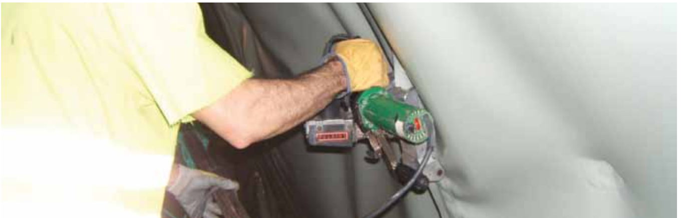
Geomembranas soldadas con máquinas automáticas de doble soldadura con canal de comprobación.
